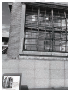
▲爆風により歪んだ窓枠。爆風は北側（爆心地側）から直撃し、この西側の窓枠は外に歪んでいる。
